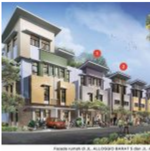
Fasade Rumah Alloggio Barat 5 dan Timur 1
