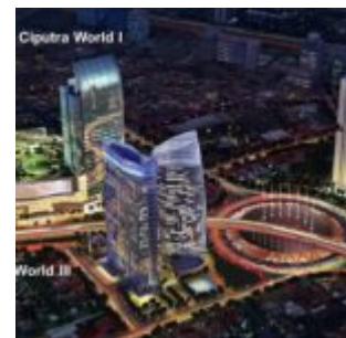
Gedung Ciputra World 2 Jakarta
