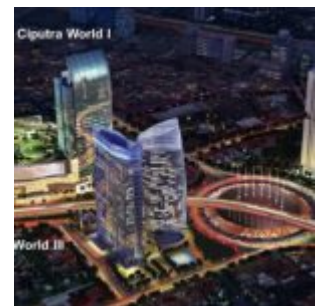
Gedung Ciputra World 2 Jakarta
