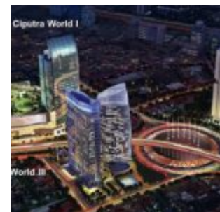
Gedung Ciputra World 2 Jakarta
